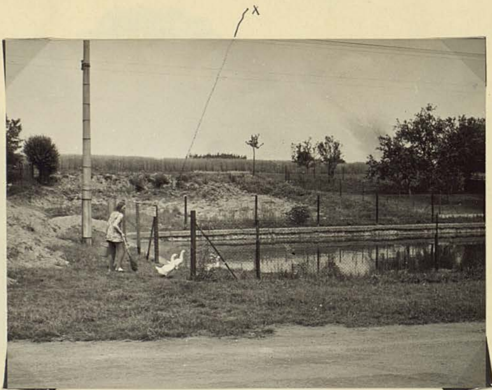
Pohled na upravený terén nad vodní nádrží v r. 1979. Přes zákal zéne Hana Kosinová do "vodní nádrže" husy.
