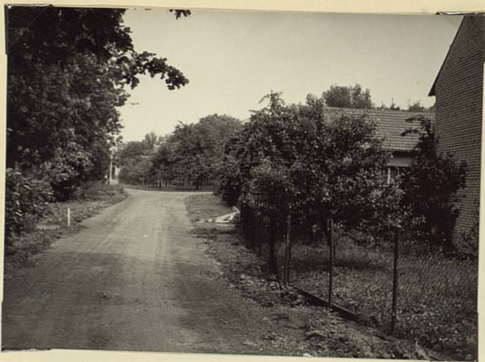
Pohled na vybud. úsek silnice od pamat. dubu.
