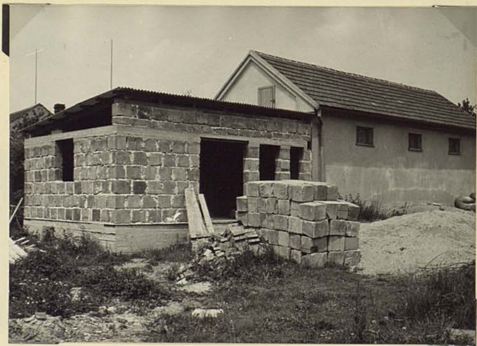
Det. pohled na stavbu skladu a požární zbrojnice.
