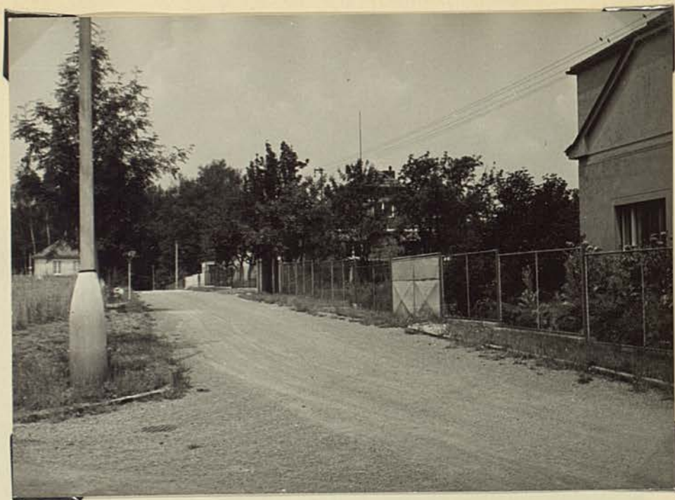
Pohled na dobudovaný úsek silnice od Konečných k Bajevovým.
