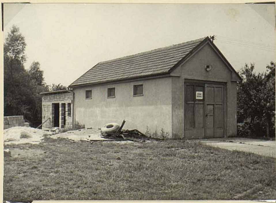
celkový pohled na novou požární zbrojnicí.
