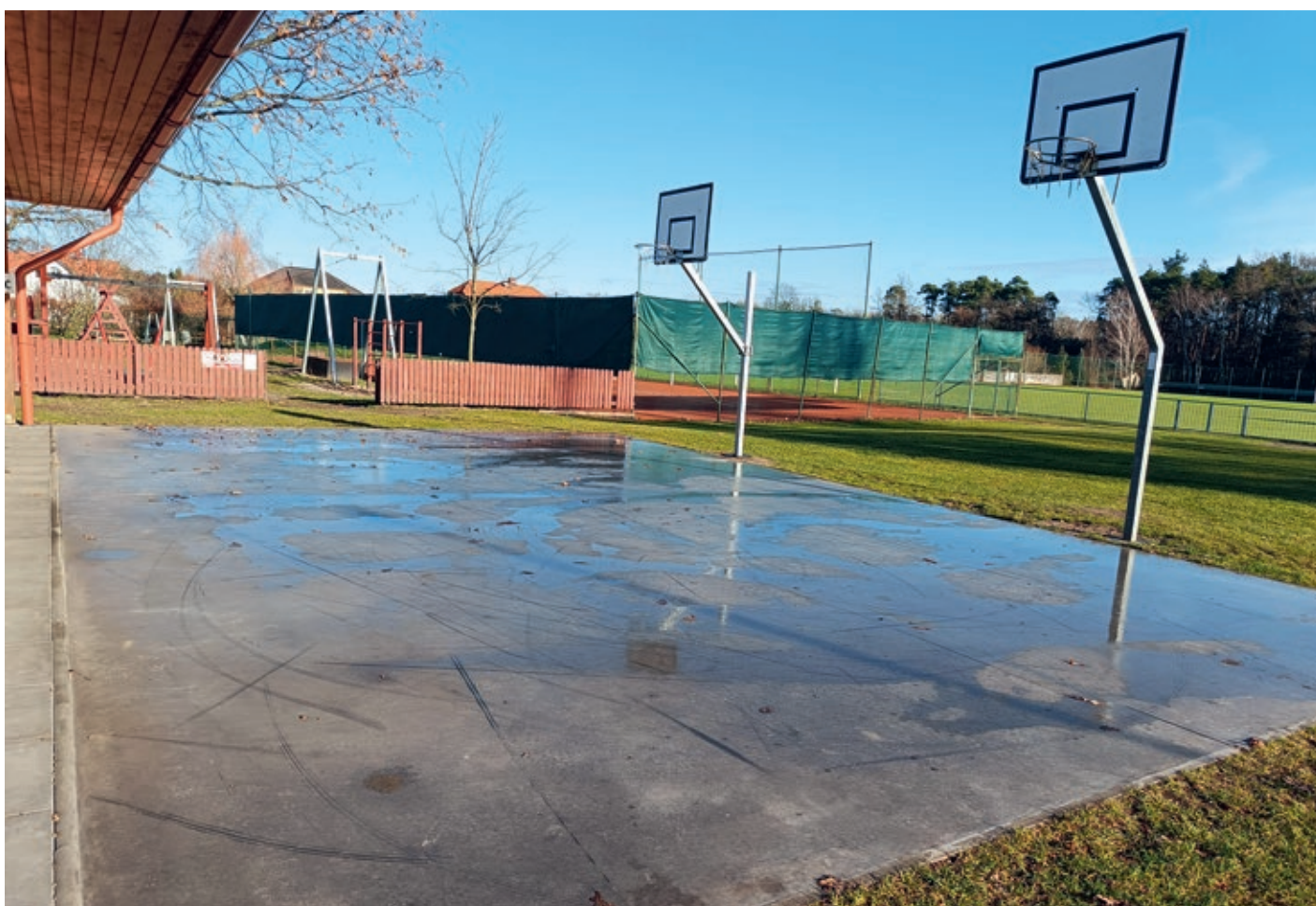
V letošním roce byla revitalizována betonová plocha před starými kabinami. K basketbalovému koši s obroučkou ve standardní výšce 3,05 m přibyl nový koš s obroučkou ve výšce 2,6 m určený pro dětské hráče, foto: -rb-
