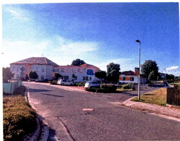
Základní škola a mateřská škola. Domek pro parkování obecní techniky.
