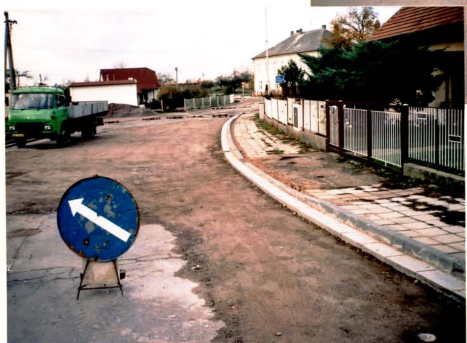
- příprava komunikace k položení asfaltového kotvení.
