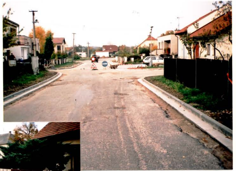
- příprava komunikace k položení asfaltového kotvení.
