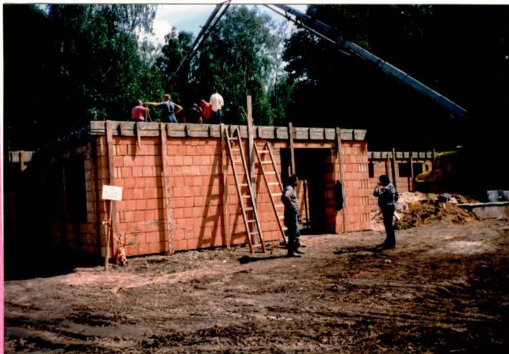
Výstavba sportovní haly na hřišti v síčce
